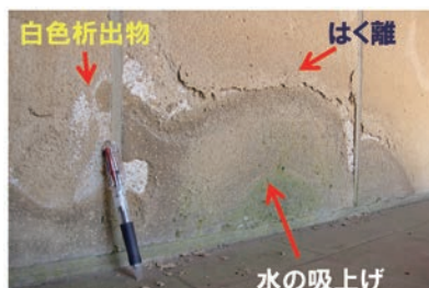
人工石材が使われている建造物で見られる塩類風化 (ベルギーの修道院における事例)
